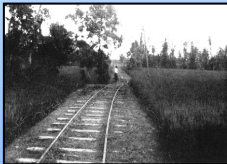
台中州內埔庄(后里鄉)舊社西方約1公里處的屯仔腳地震斷層露頭，製糖會社的鐵軌(原為直線)扭曲變形，北側地塊下沉45公分並向東移動140公分。
