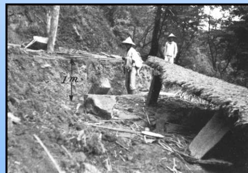
新竹州獅潭庄(苗栗縣獅潭鄉)上大窩之獅潭斷層西側隆起約1公尺，位於斷層上的民宅全倒
