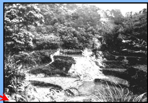
新竹州獅潭庄(苗栗縣獅潭鄉)神卓山溪谷之獅潭地震斷層露頭，東側地塊陷落約1.7公尺(地震前已有3-4公尺的落差)。
