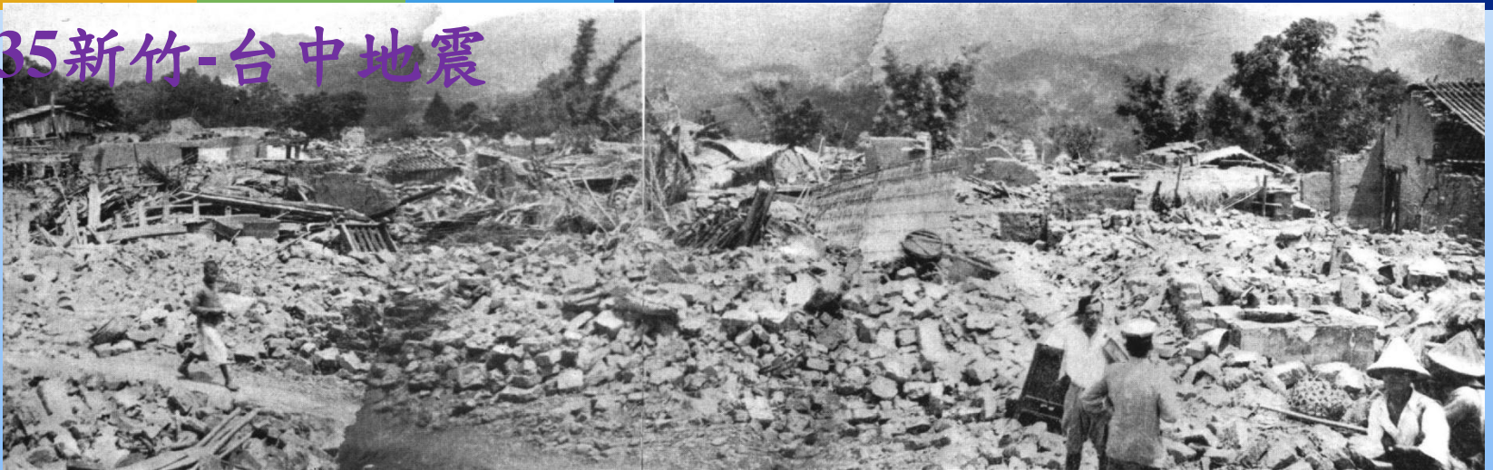
新竹州峨眉庄峨眉(新竹縣峨眉鄉)在地震後成為一片廢墟，峨眉總戶數為167戶，全倒167戶，全倒率為100%。
