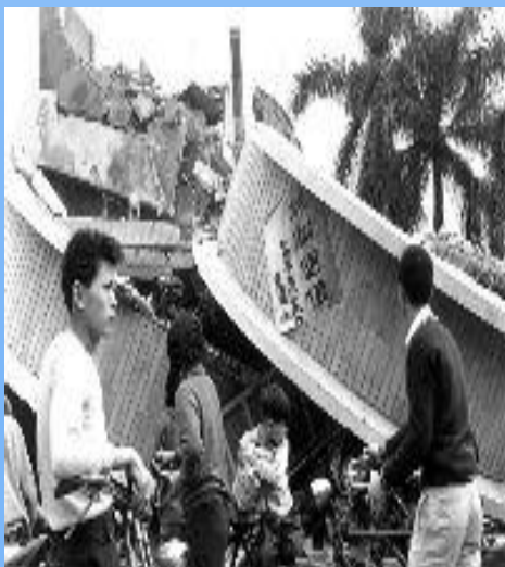
嘉義市光彩街184號羅小兒科醫院(1963年8月完成之三樓鋼筋混凝土建築物，工程費84萬元)，向NW倒塌，屋主一家4口於地震發生時趨避於浴室內而倖免於難(1964年1月)
