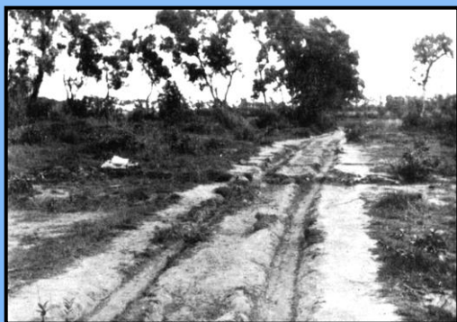
台中州新庄子西方道路的屯仔腳地震斷層露頭，道路被斷層切割成十多段，水平與垂直總錯位量約30公分，斷層二側的民宅全倒
