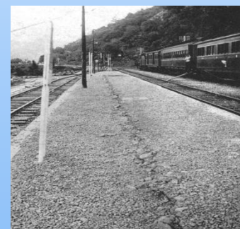
大安(泰安)火車站月台上之龜裂線
