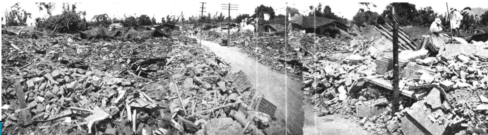
台中州豐原區埔庄(台中縣后里鄉)屯子腳之慘狀，屯子腳總戶數735戶，全倒509戶，半倒46戶，破損128戶，住家全倒半倒與破損率為98%；總人口數4,578人，死亡440人、重傷210人、輕傷1,081人，死傷率達37.5%。
