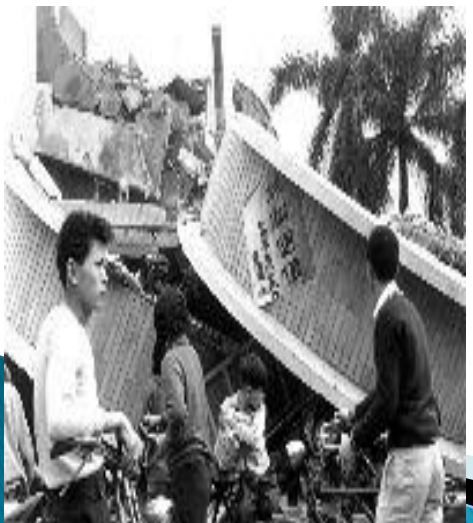
嘉義市光彩街184號羅小兒科醫院(1963年8月完成之三樓鋼筋混凝土建築物，工程費84萬元)，向NW倒塌，屋主一家4口於地震發生時趨避於浴室內而倖免於難(1964年1月)
