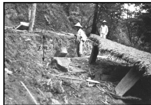
新竹州獅潭庄(苗栗縣獅潭鄉)上大窩之獅潭斷層西側隆起約1公尺，位於斷層上的民宅全倒
