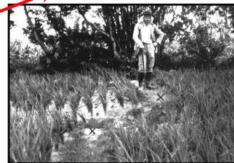
左圖西方約200公尺三角子稻田中的斷層露頭，斷層走向N72°E，圖中符號"X"為地震前同一處的田埂，北側地塊下沉45公分並向東方移動120公分
