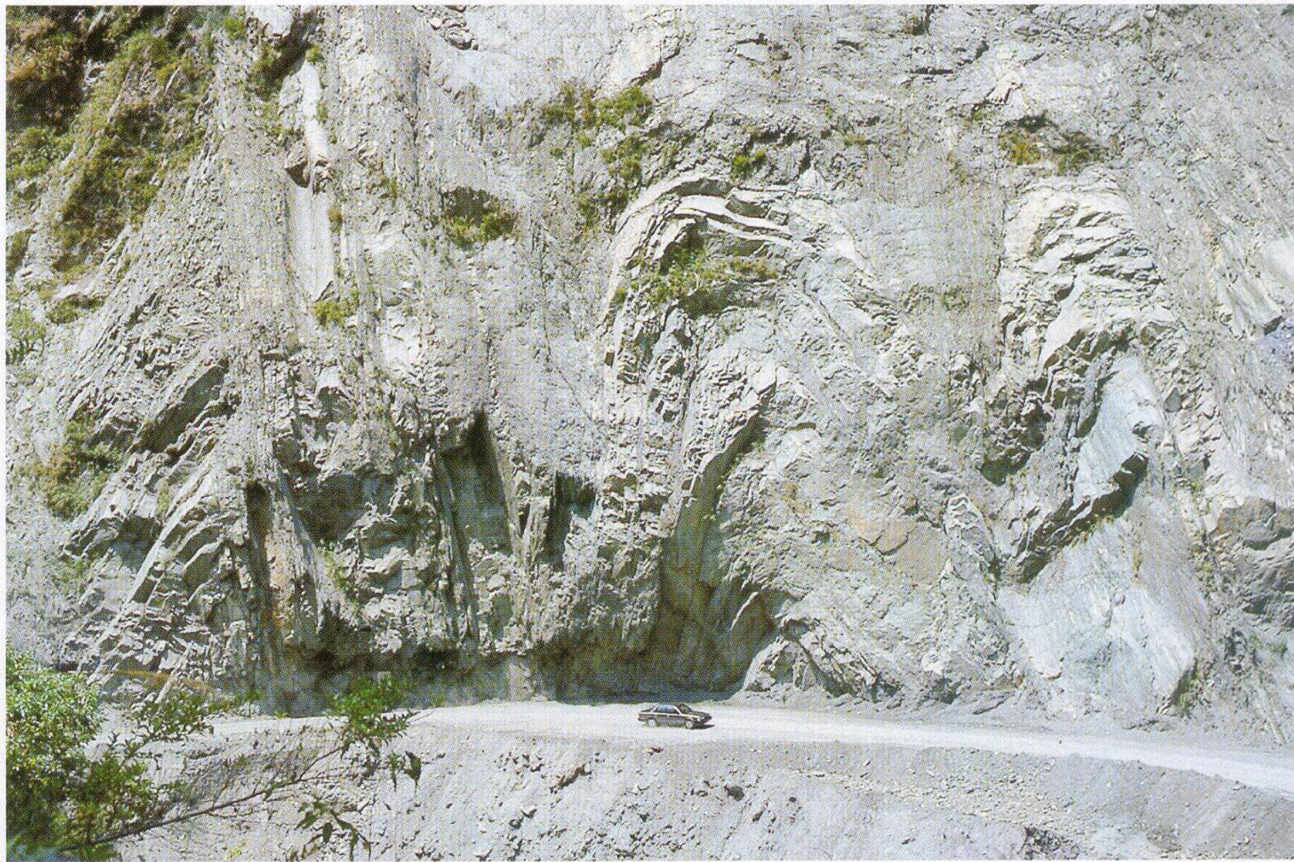
2-10 南部橫貫公路利稻橋附近露出的利稻橋層，主要由厚層變質砂岩組成，內夾板岩或千枚岩層。
